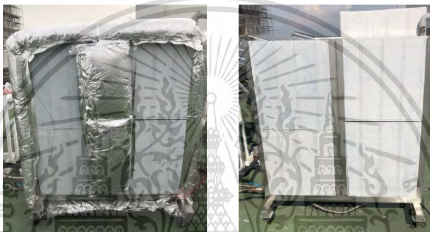
รูปที่ 3.11 การหุ้มฉนวนกันความร้อนทาวเวอร์เป็นห้องกักเก็บความร้อนผลิตไฟฟ้า
