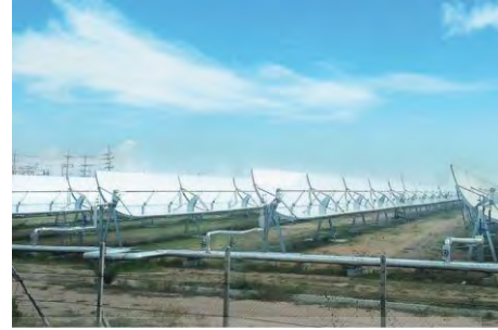
รูปที่ 2.3 กระบวนการผลิตไฟฟ้าในโรงไฟฟ้าพลังความร้อนจากแสงอาทิตย์ระบบรางพาราโบลิก โรงไฟฟ้าพลังความร้อนจากแสงอาทิตย์ ระบบรางพาราโบลิกโรงแรกที่ผลิตในเชิงพาณิชย์ในจังหวัด สุพรรณบุรี
