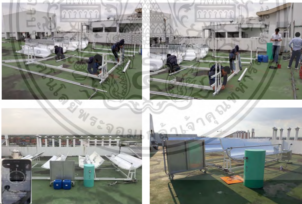
รูปที่ 3.20 ติดตั้งจริงต้นแบบเทอร์โมอิเล็กทริกขนาดเล็กแบบผลิตไฟฟ้าจากความร้อนของการรวมแสงอาทิตย์ร่วมกับสารเก็บกักความร้อน
